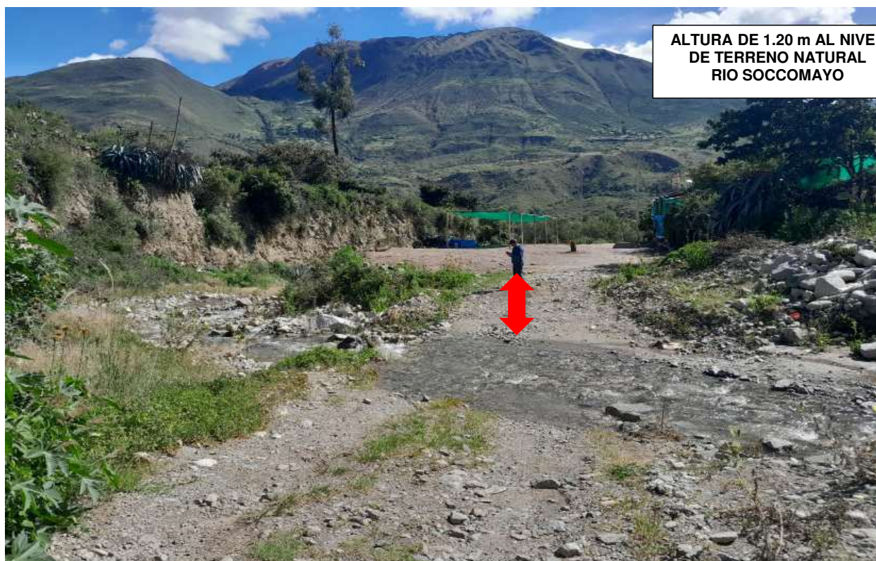
FIGURA N°02 SE VISUALIZA LA VULNERABILIDAD DE LA MARGEN DERECHA DEL RIO SOCCOMAYO QUE TIENE UNA TALUD DE CAUCE CON UNA ALTURA APROXIAMDA DE 1.20 M E INCLINACIÓN DE UNOS 60°. SE VISUALIZA QUE REQUIERE UNA PROTECCION Y LIMPIEZA
