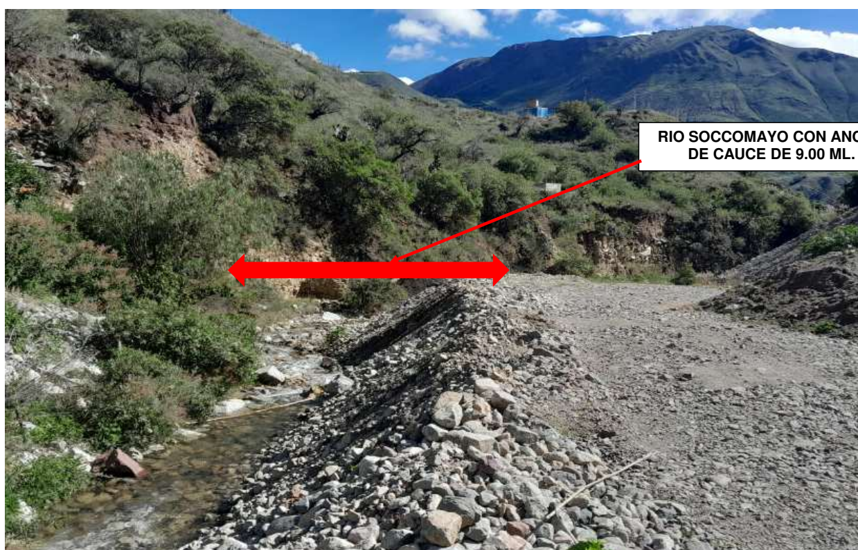
FIGURA N°03 SE VISUALIZA LA LIMPIEZA DEL CAUCE QUE FUE REDUCIDO A UN ANCHO DE 4.00ml. EN EL TRAMO MAS CRITICO
